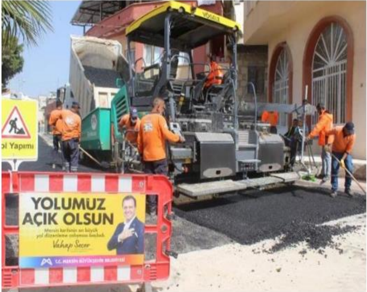
Kazanlı'ya sıcak asfalt
